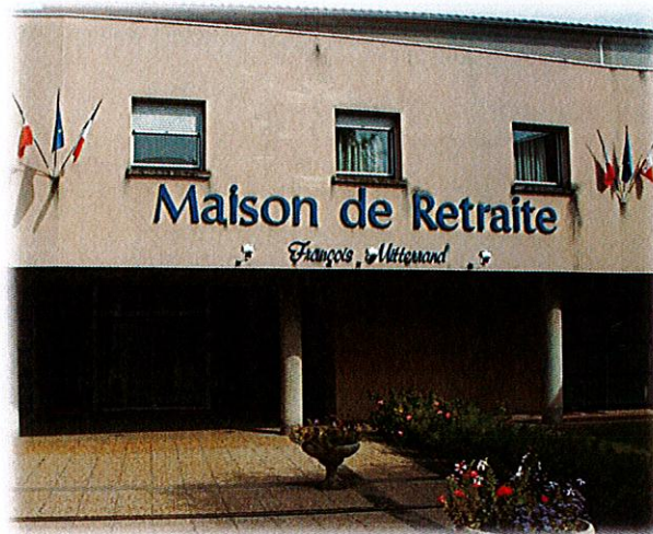
Entrée principale de l'EHPAD
